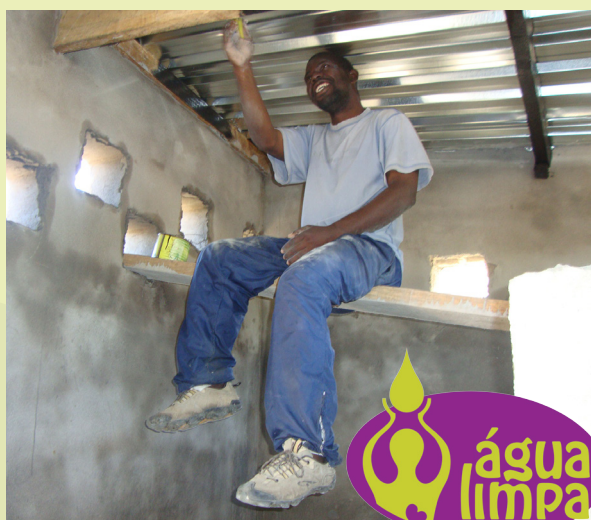
Um bloco sanitário em construção
