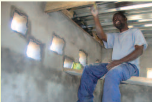
Bouwen voorzieningen: de bouw van een toilet unit
